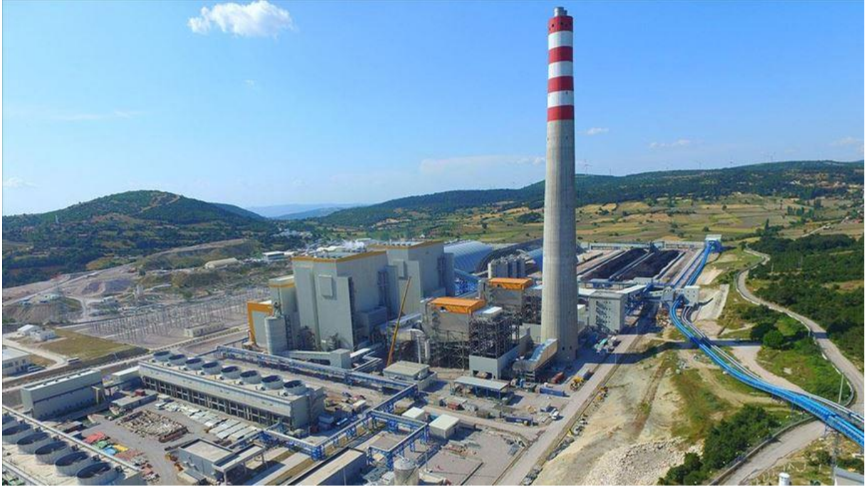
Şekil 41: Kolin Termik Santral İnşaatı- Soma
