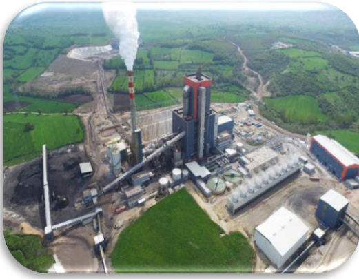
ODAŞ Termik Santrali
