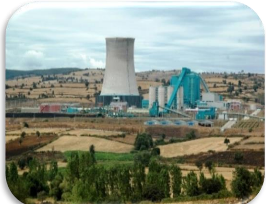
EÜAŞ 18 Mart Termik Santrali
