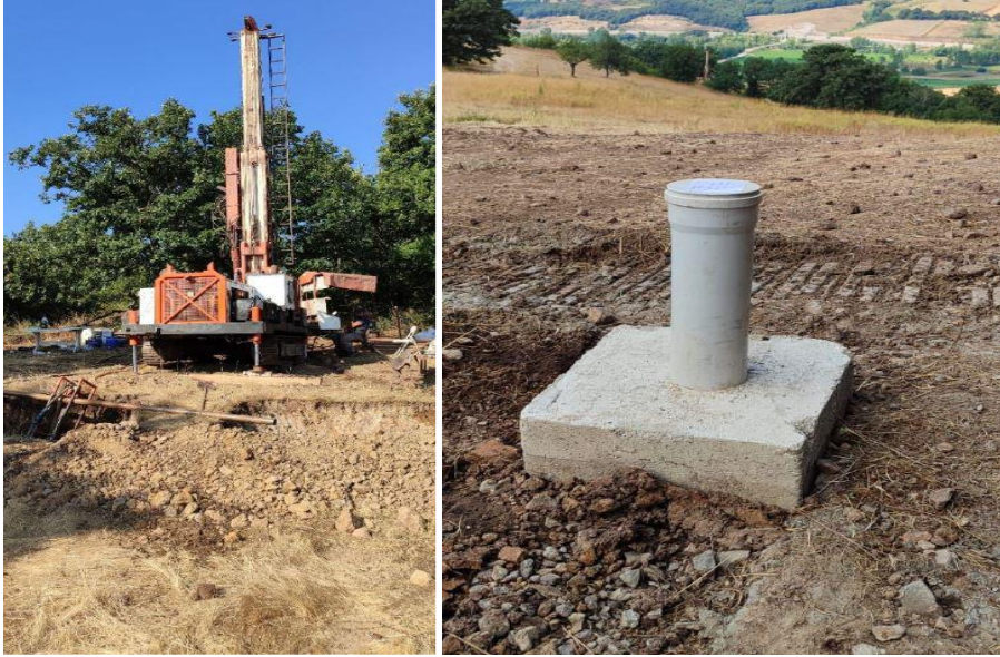
Sondaj çalışmaları ve bitirilen CMK 45 kuyusu
