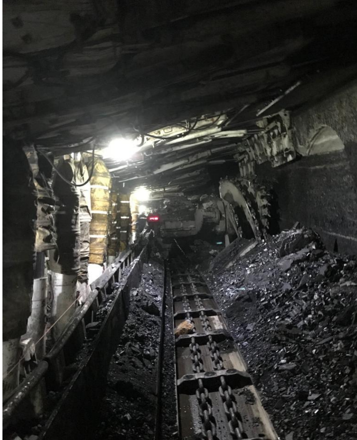
Şekil 52: Ömerler Mekanize Yeraltı Projesi
