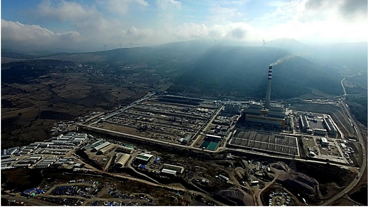
Şekil 40: Kolin Termik Santral İnşaatı- Soma
