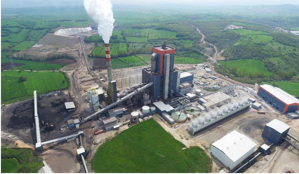
Odaş Termik Santrali
