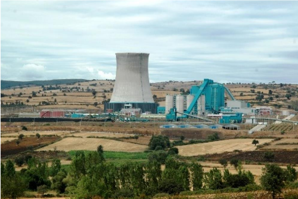
EÜAŞ 18 Mart Termik Santrali
