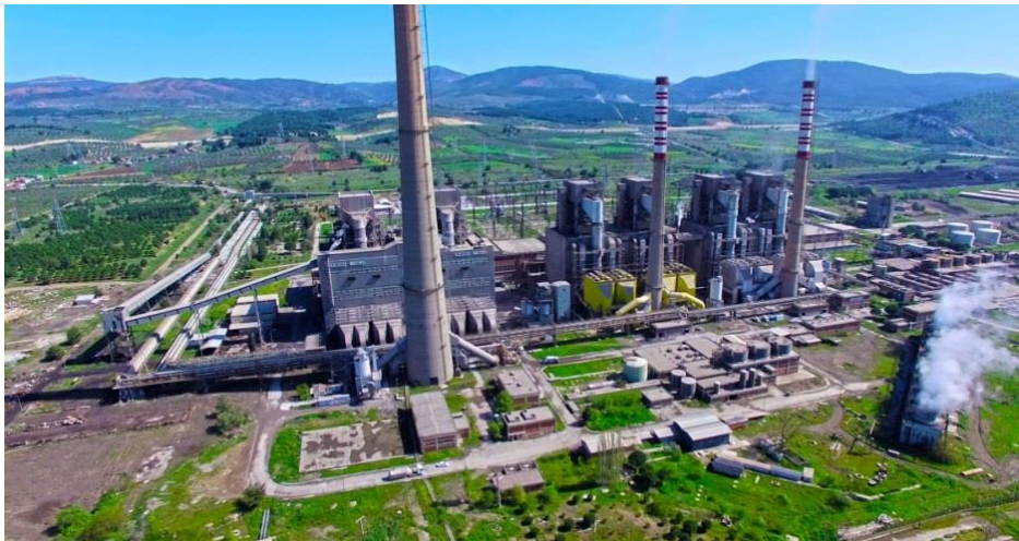
Soma Termik Santrali
