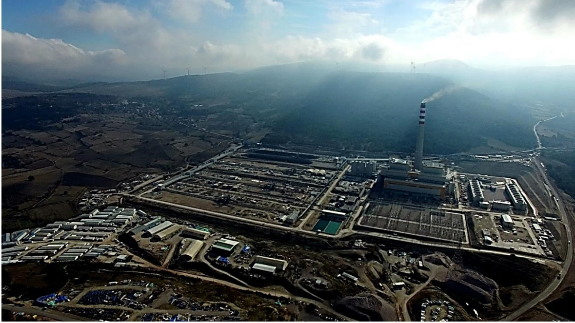
Şekil 41: Kolin Termik Santral İnşaatı- Soma
