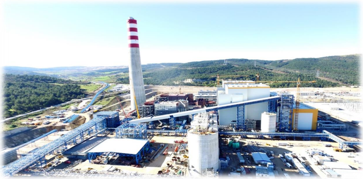
Şekil 38: Kolin Termik Santral İnşaatı- Soma
